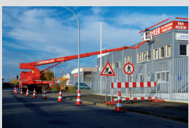
Beschilderung und Baustellenabsicherung
